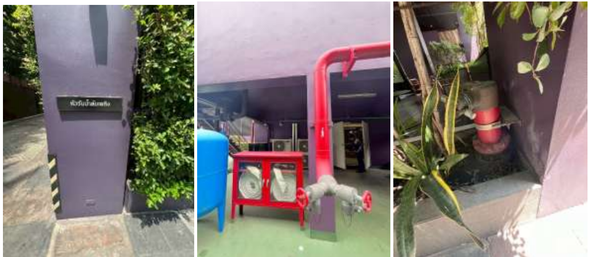
ภาพที่ 27 น้ำสำรองสำหรับดับเพลิงและหัวรับน้ำดับเพลิง
