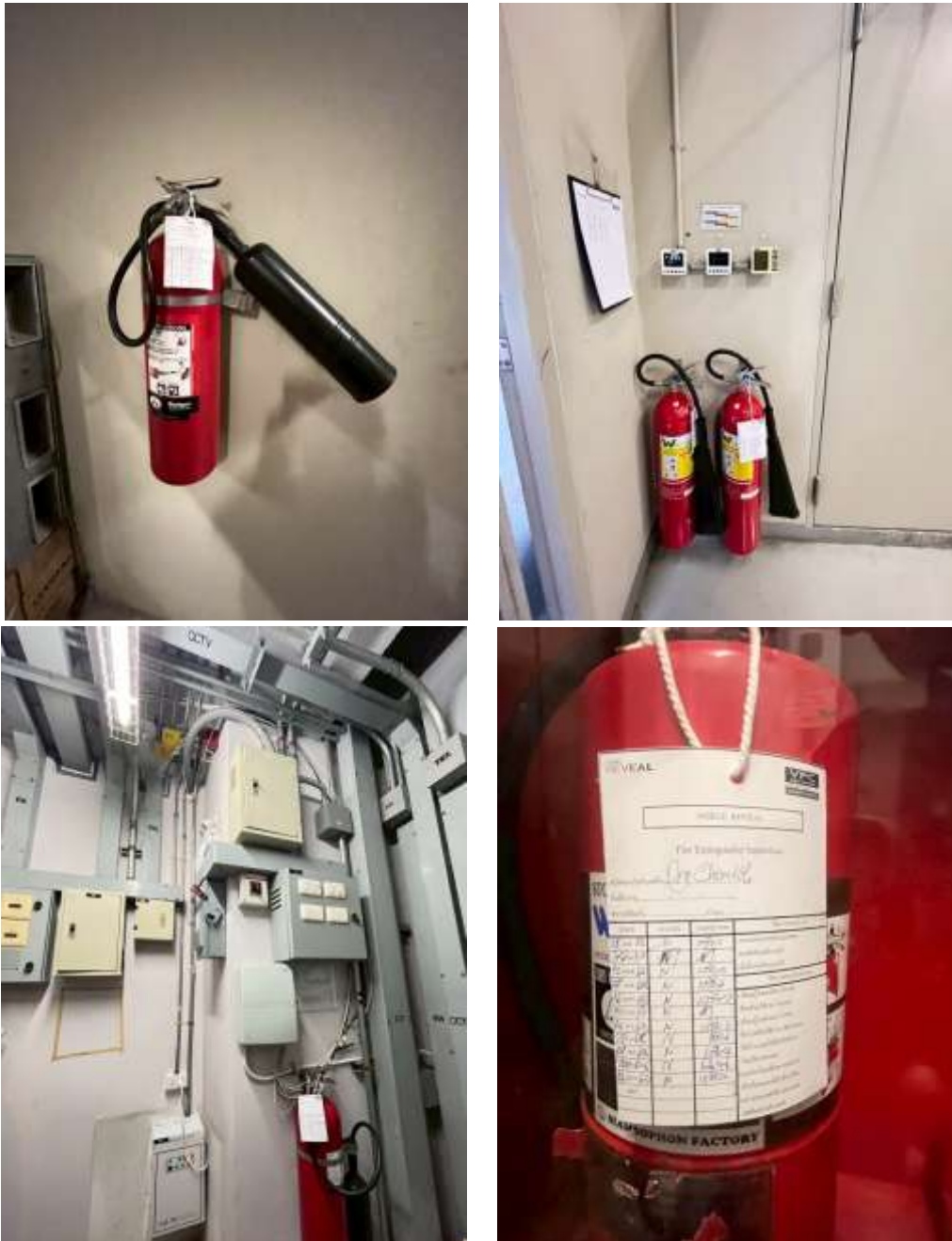
ภาพที่ 29 เครื่องดับเพลิงแบบมือถือ และการตรวจสอบ
