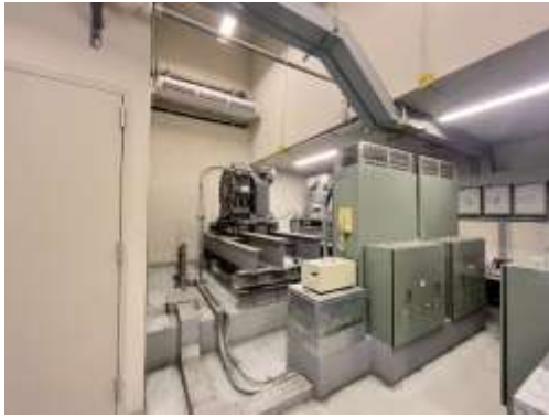
ภาพที่ 32 ระบบจ่ายไฟฟ้าสำรอง
