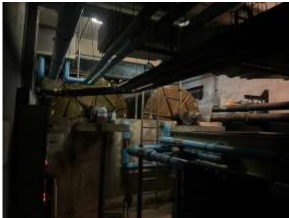
ภาพที่ 5 ระบบบำบัดน้ำเสียแบบ RBC
